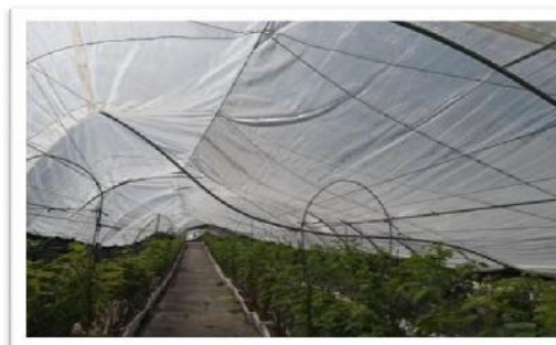
Daños en invernaderos
